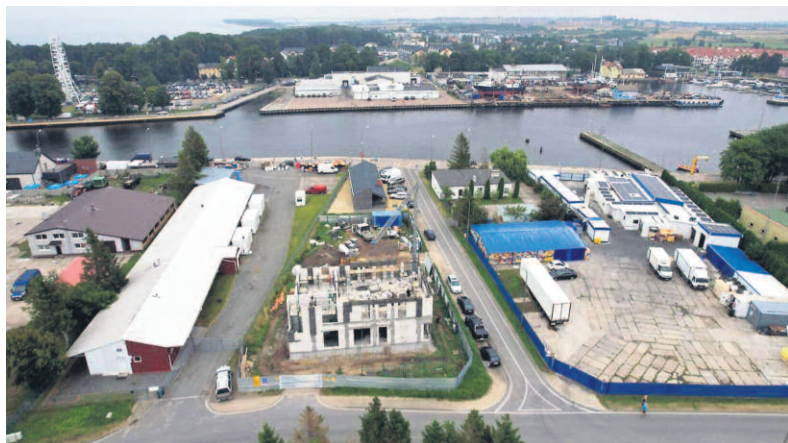
To pierwszy etap. Prace finansowane są z dotacji unijnej i środków własnych DLGR
