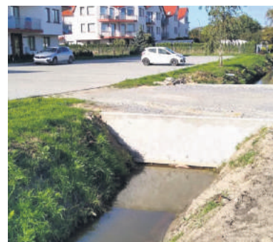
Rów melioracyjny wzdłuż ul. Północnej
