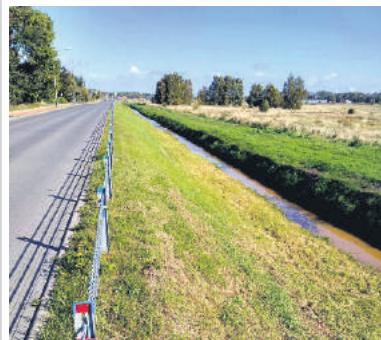
Rów melioracyjny przy ul. Nadmorskiej
