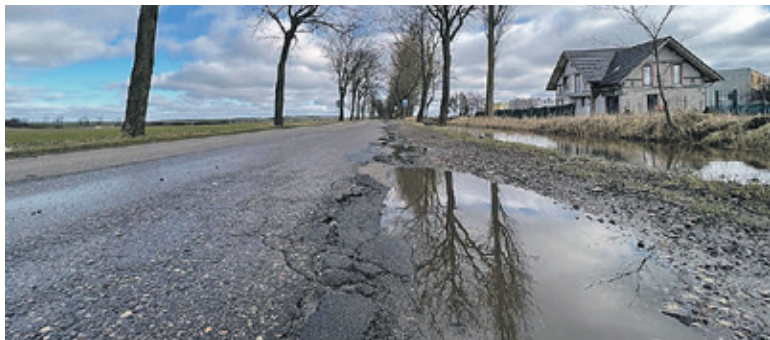
Obecna DW 203 na odcinku pomiędzy Cisowem a Zakrzewem.
