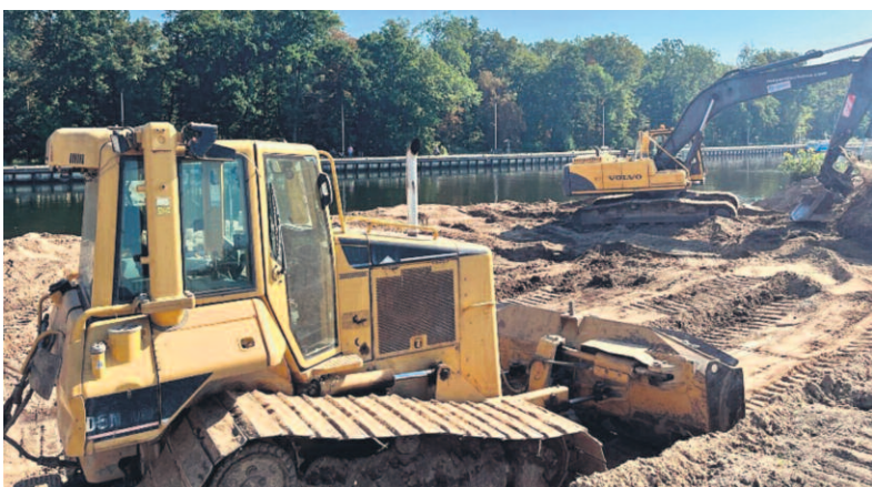
Prace przy budowie nowego nabrzeża przeładunkowego.
