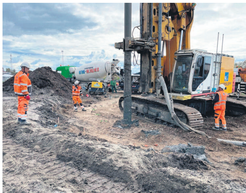
Trwają roboty polegające na wzmocnieniu słabego podłoża pod wykonanie drogi wewnętrznej. Roboty polegają na wierceniu / wpuszczaniu wylewanych pali betonowych w długości 20 i 18 m i średnicy 30 cm. Dla budowanego odcinka drogi dł. 483 m Wykonawca wykona – 1 480 szt. pali a ich łączna długość to ponad 28 km
