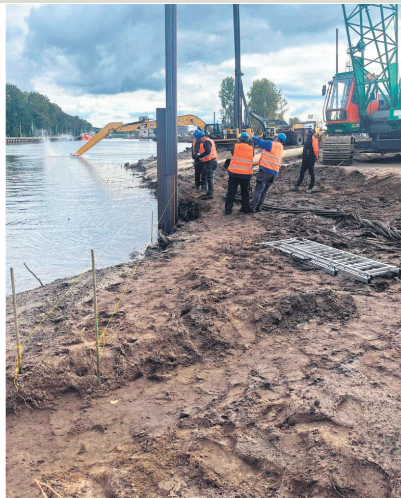
Wykonawca przystąpił do pograżania grodzic stalowych wyznaczając tym samym linię przebiegu nowego nabrzeża typu ciężkiego w Porcie Morskim Darłowo
