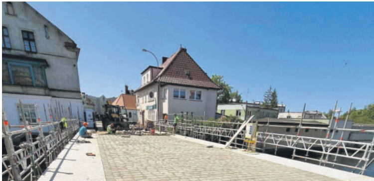
Montowane nowe barierki na moście będą nawiązywały do tych przedwojennych.
