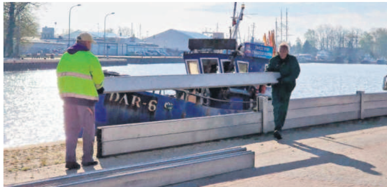
Sezon zagrożenia powodzią z powodu cofki za nami. Pracownicy MPKG ściągają zapory przeciwpowodziowe w porcie.
