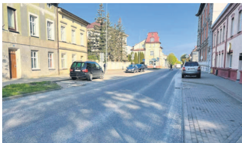
Zakończyła się wymiana nawierzchni przy ul. Żeromskiego. W przeciągu najbliższych dni namalowane zostanie oznakowanie poziome. W związku z powyższym prosimy o zachowanie ostrożności, w szczególności w pobliżu przejść dla pieszych.
