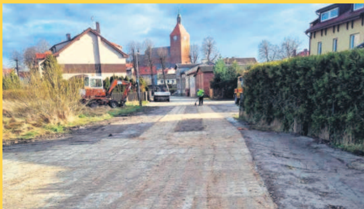
Łącznik przy ul. Wyszyńskiego (wyrównanie terenu i ułożenie płyt yomb).
